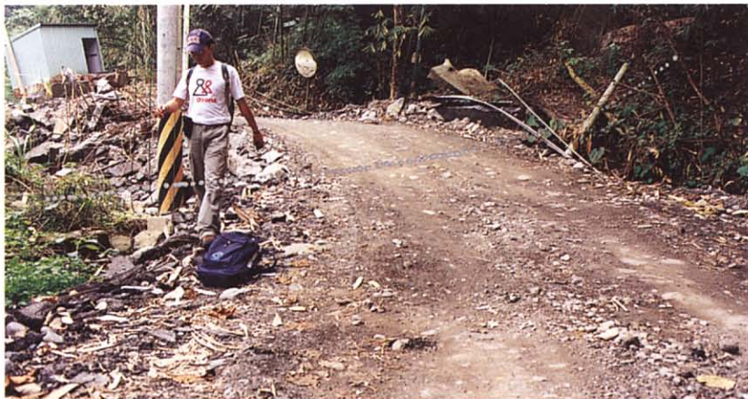
C. 集集地震斷層南段在嶺腳（圖三，TCS01）因地震所形成的崖，崖兩側高差約1.5公尺。
