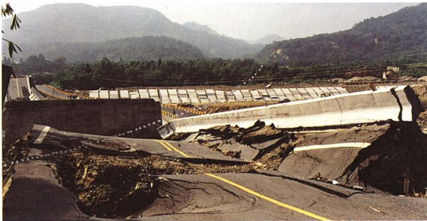
B. 桶頭附近（圖三，TCS06）地震斷層穿越清水溪錯斷桶頭橋與河堤。
