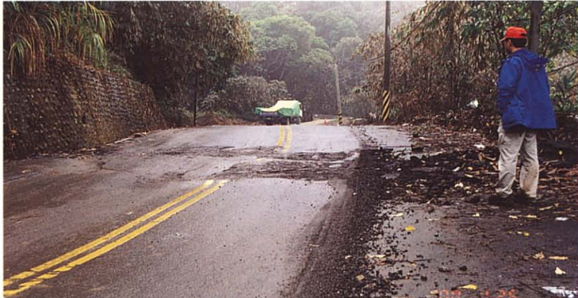
B. 集集地震斷層南段在嶺腳北方因地震所形成的崖，崖兩側高差約0.2公尺。
