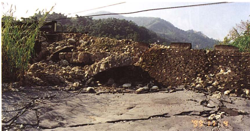
C. 地震斷層錯斷安溪橋（圖三，TCS07），崖兩側高差約0.5公尺。
