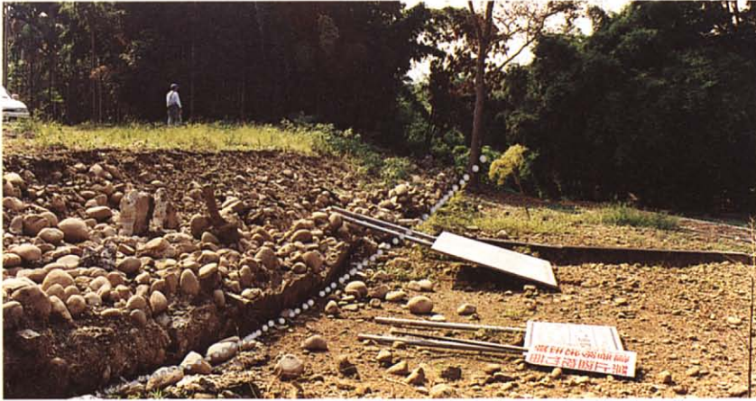
A. 坪頂台地上（圖三，TCS05）地震斷層所形成的崖，崖兩側高差約0.4~0.6公尺。
